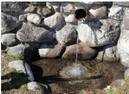
Фото 3а. Вариант исполнения упрощенного короба родника
