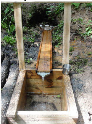
Фото 3. Оборудование истока и места забора воды у родника нисходящего типа.
